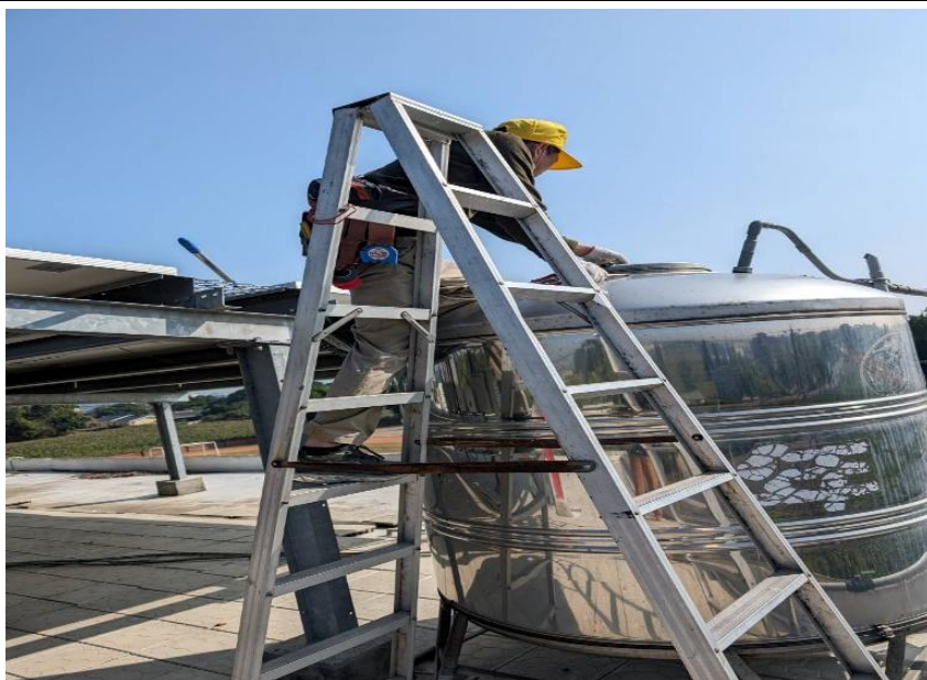
定期清洗水塔
